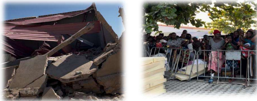
Figura 4: Resultado das inundações no rio Cavaco, Benguela, Angola.
